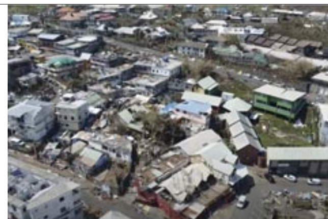
▲ 90 % des habitants de Mayotte ont perdu leurs toits après le passage du Cyclone Chido.
